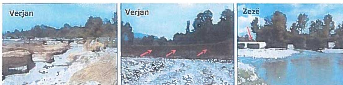
Figura 4.23 Deformime shtratore, erozion i brigjeve dhe rrezikim i objekteve inxhinierike
